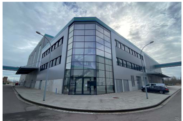
Das neu errichtete Produktionsgebäude mit einer Fläche von mehr als 8 000 m 2 im Industriegebiet von Weißandt-Görlau in Sachsen-Anhalt.
